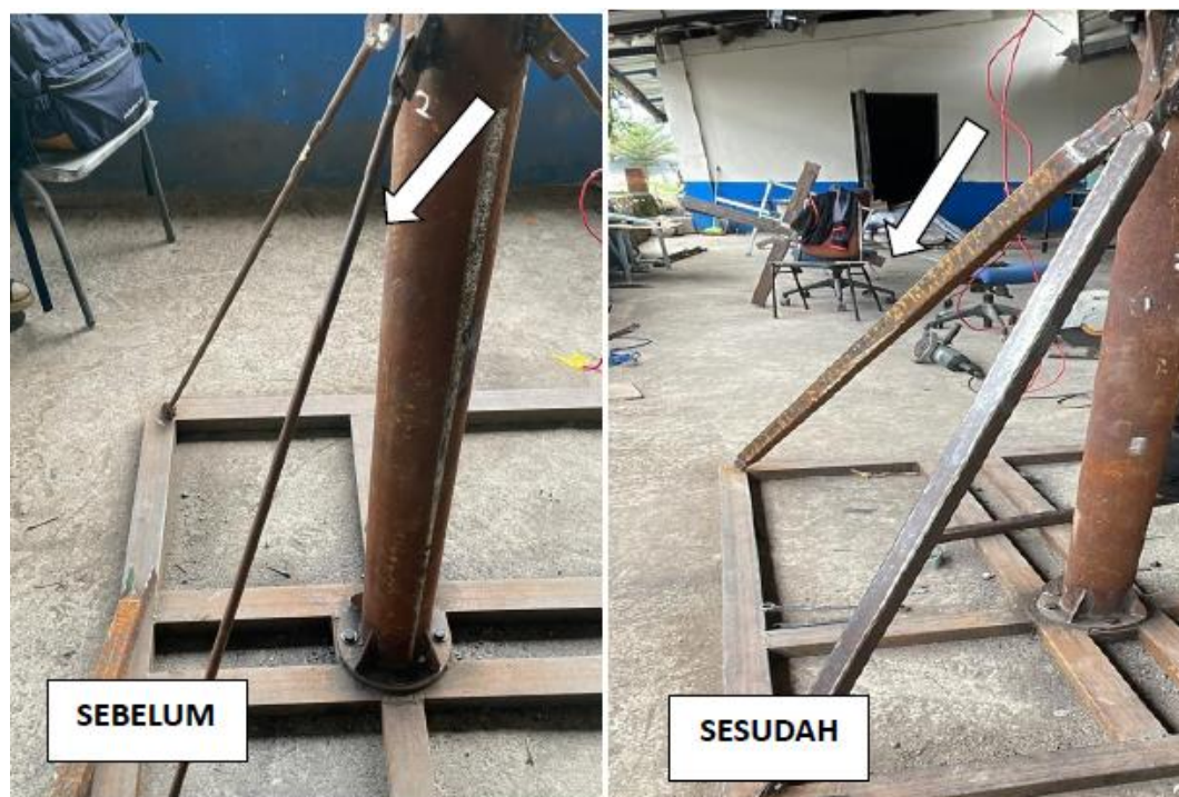
Gambar 6. Penggantian tiang penyangga
